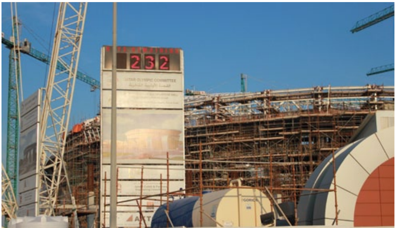
Die Ali bin Hamad Al Attiya Arena (im Bild als Baustelle im Januar 2014) ist für die Handball-Weltmeisterschaft der Männer in Katar, die im Januar 2015 stattfand, im Dohaer Stadtteil Al Sadd gebaut worden. Auch Bilder dieses Stadions wurden in der internationalen Berichterstattung als vermeintliche Fußball-WM-Baustellen ausgegeben – jedoch als solche noch gar nicht existierten.
