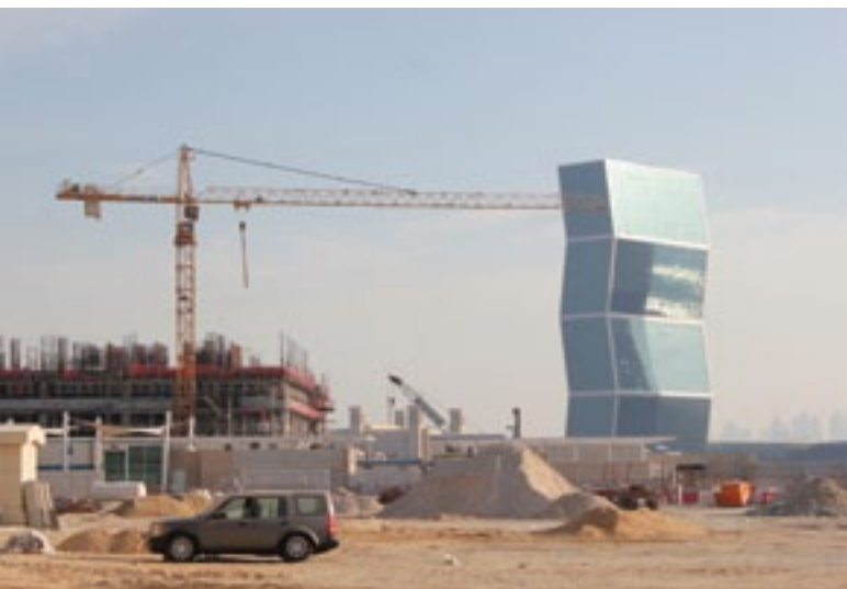
Die Retortenstadt Lusail City nordöstlich von Doha wird buchstäblich aus dem Sand gehoben. Von ihren Baustellen aus lässt sich an einem arbeitsfreien Freitag einer der „Zig-Zag-Towers“, Wahrzeichen der Stadt Doha, betrachten.
